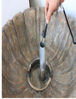
Reposer soigneusement le bol sur son côté. Passez le cordon d'alimentation de la pompe vers le bas du tuyau de cordon.
