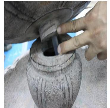
Passez la tuyauterie par le milieu puis plus bas et fermez à clef la petite cuvette à la canalisation verticale.
