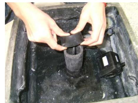
Cord fits in grooves on pump and bottom. Cover pipe by firmly fitting rubber cap on pipe. / Ajustements de corde dans les cannelures sur la pompe et le fond. Couvrez la pipe en adaptant fermement le chapeau en caoutchouc sur la pipe.
