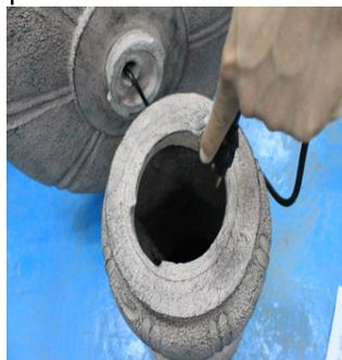
Reposez soigneusement la cuvette de son côté et passez la corde de pompe en bas du piédestal.
