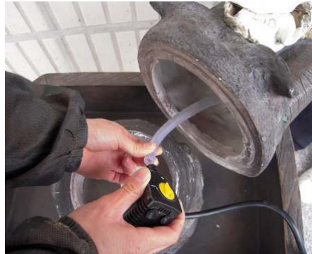
Reliez la tuyauterie du morceau supérieur de la fontaine à la pompe.
